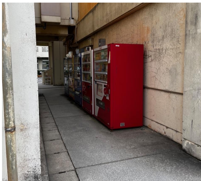
図 1 R7～10 設置場所
